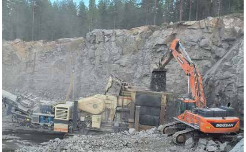
KMV Rahikainen Oy kalliomurskaustöissä.
